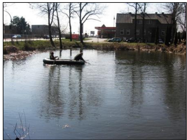
Schlauchbooteinsatz zur Verlegung des Drausyschlauches in einer Schleife
