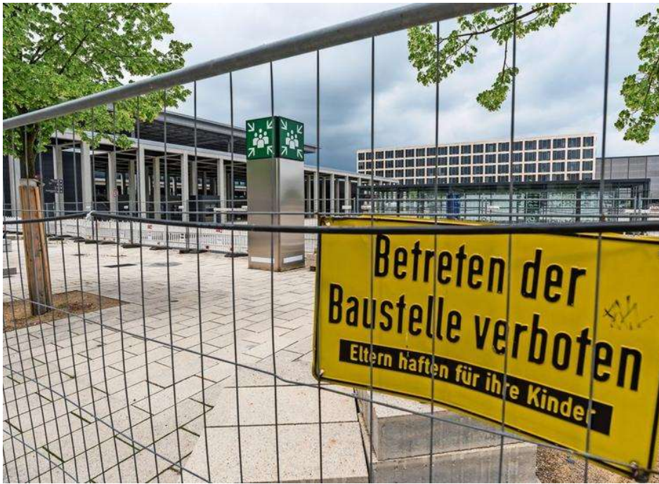
Ein Bauzaun am Hauptstadtflughafen BER. Quelle: Patrick Pleul/dpa
